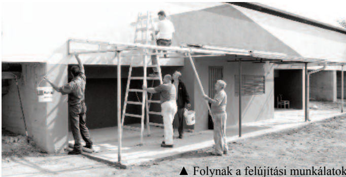
▲ Folyznak a felújítási munkálatok
